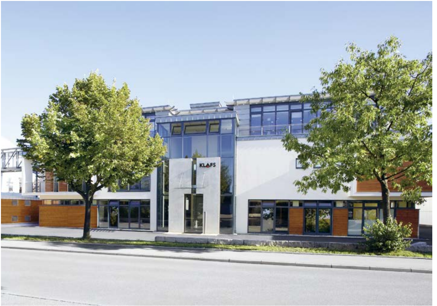
House of Sauna & Spa, Schwäbisch Hall.
